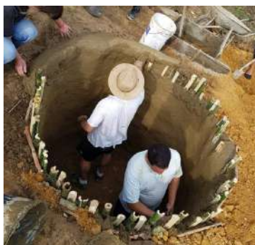
Construção da Biofossa - C.Q. Restinga - Lapa/PR. Fonte: Arquivo Quilombo, 2019.
